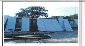
Foto 2: Cambio de techado y reforzamiento de costaneras.
